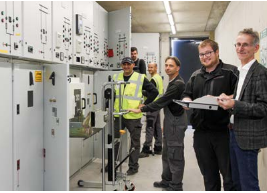
Unser leistungsstarkes Team macht das Dachauer Stromnetz fit für die Zukunft
