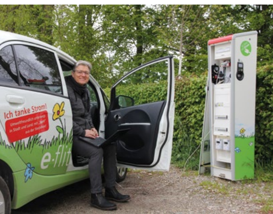
Dirk Rücker, Experte für E-Mobilität bei den Stadtwerken Dachau, installiert neue E-Ladesäulen auf dem Parkplatz am Dachauer Schloss.
