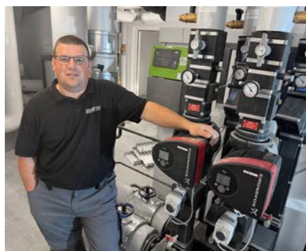
Johannes Fischer, Sachgebietsleiter Wärmeversorgung koordinierte das Energieprojekt in der Wohnanlage in Dachau-Ost: von der Planung bis zur erfolgreichen Inbetriebnahme.
