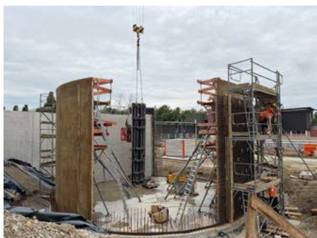
Auf der Baustelle nimmt die neue Anlage Gestalt an: Die Fundamente sind gelegt, und die Wände der neuen Becken werden Schritt für Schritt aufgebaut. Bevor sie betoniert werden können, sind präzise Arbeiten an Bewehrung und Schalung erforderlich.
