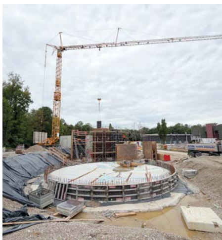
Auf der Baustelle nimmt die neue Anlage Gestalt an: Die Fundamente sind gelegt, und die Wände der neuen Becken werden Schritt für Schritt aufgebaut. Bevor sie betoniert werden können, sind präzise Arbeiten an Bewehrung und Schalung erforderlich.
